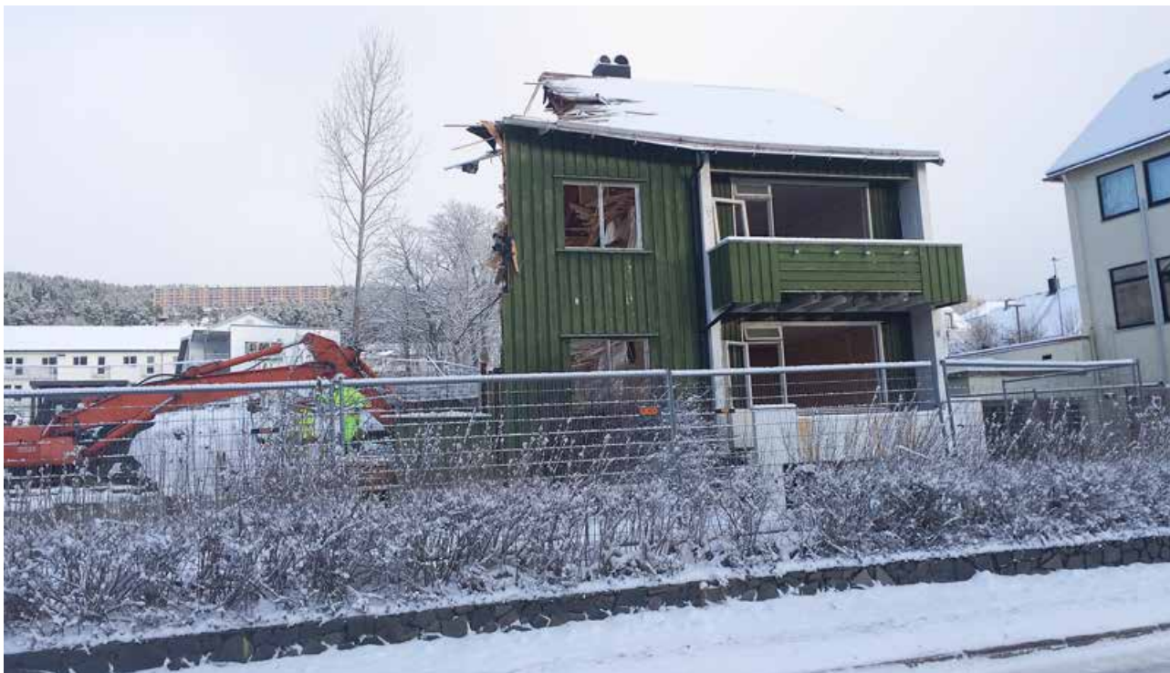
Riving av Øvre veg 5.
