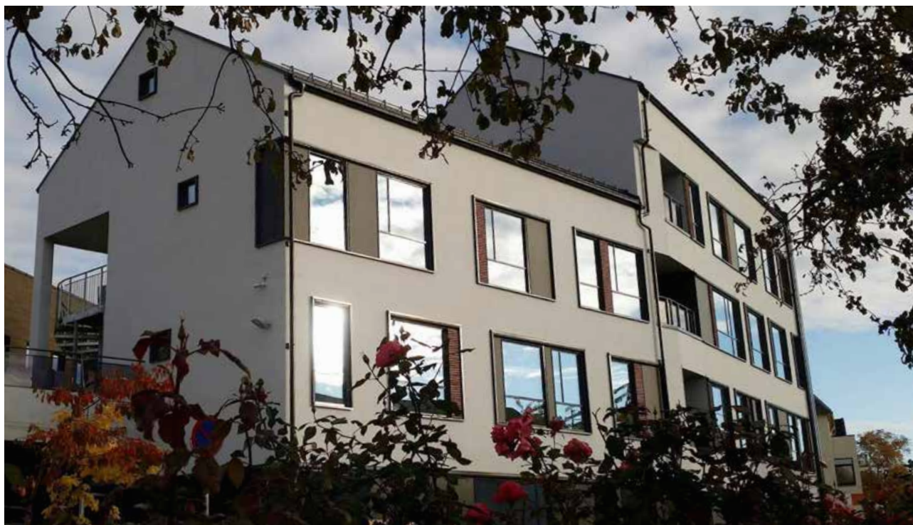
Nytt bygg klart til innflytting.
